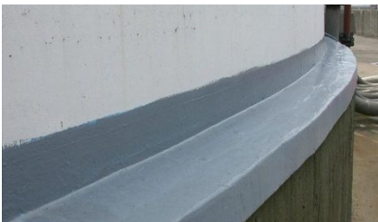
Tank annular plate edge
