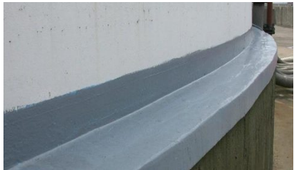
Tank edge transition
